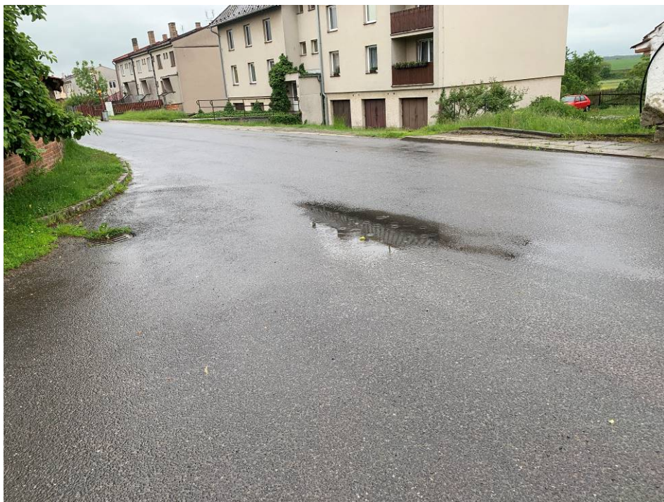
Nerovnosti v napojení komunikací – Komunikace – Jetětice – Stehlovice – Branice
