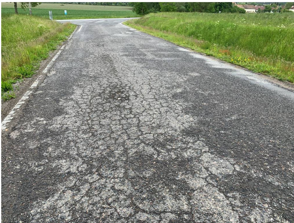
Plošné poruchy vozovky mozaikové, síťové trhliny, ztráta asfaltového tmelu, olamování okrajů vozovky, prolomení vozovky - Komunikace – od uzlu 2223A061 do uzlu 2241A035 (Podolí I)
