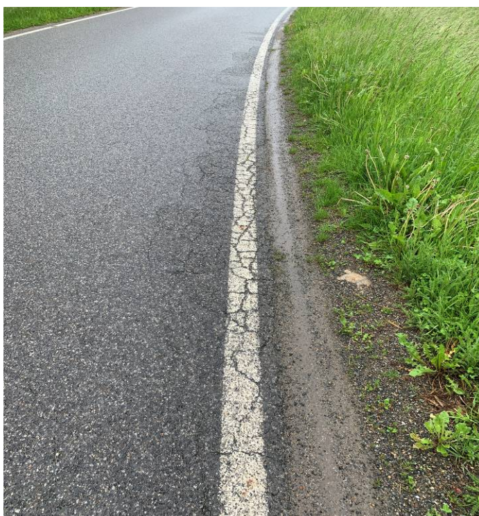
Porucha trhlina mozaiková – Komunikace – Jetětice – Stehlovice – Branice
