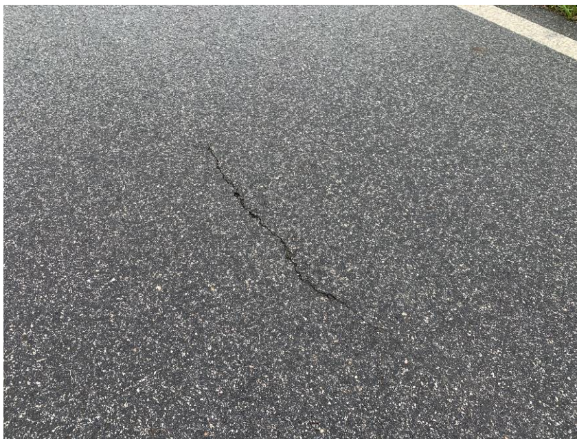
Porucha trhlina úzká podélná – Komunikace – Jetětice – Stehlovice – Branice
