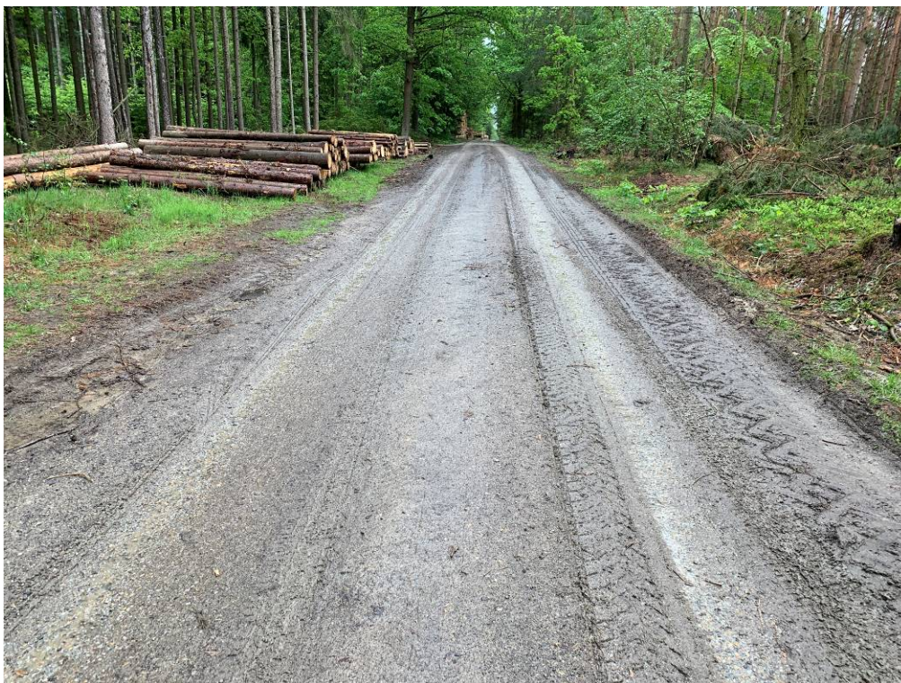
Porucha – Vyjeté koleje -Stávající lesní cesty Levý Břeh
