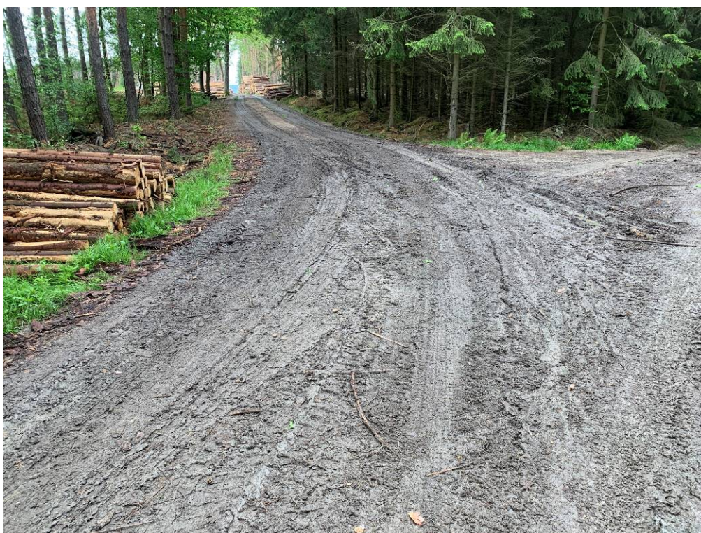
Porucha výtluk, prolomení vozovky - Stávající lesní cesty Levý Břeh
