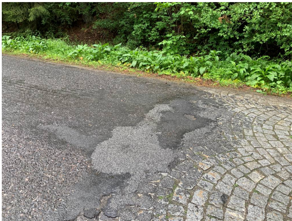
Přechod typů různých typů konstrukce - Komunikace – od uzlu 2223A061 do uzlu 2241A035 (Podolí I)
