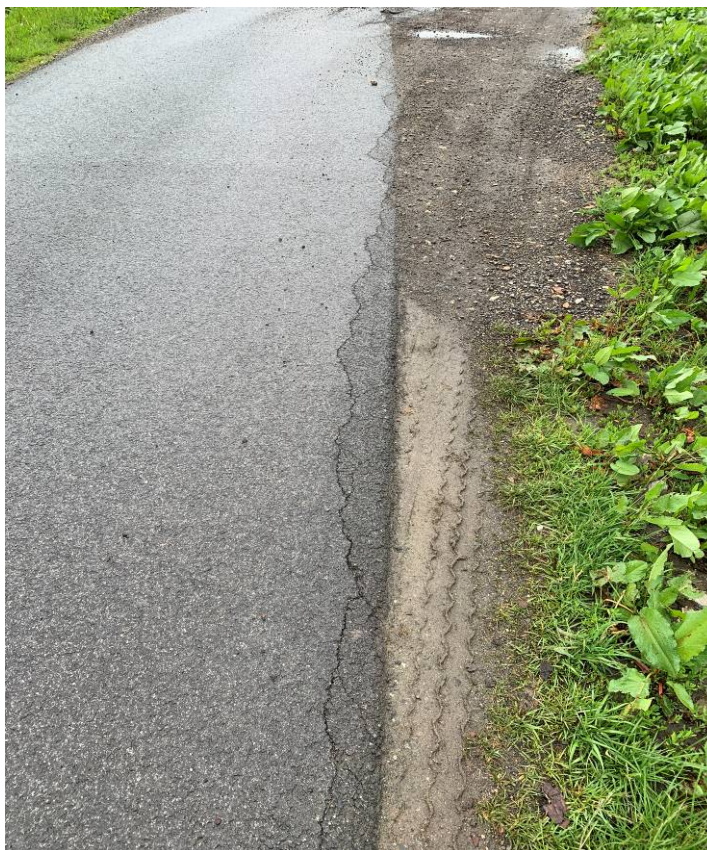
Porucha: Olamování okrajů vozovky - Místní komunikace do části obce Jetětické Samoty
