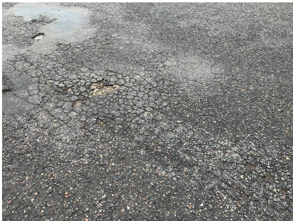
Porucha výtluk, mozaikové trhliny, ztráta asfaltového tmelu, porucha vysprávek - Komunikace – od uzlu 2223A061 do uzlu 2241A035 (Podolí I)
