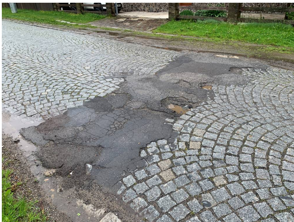
Stávajících stav vysprávek – Komunikace – Jetětice – Stehlovice – Branice
