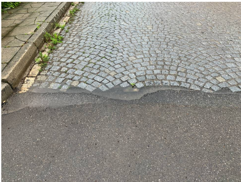
Nerovnosti v přechodech konstrukce – Komunikace – Jetětice – Stehlovice – Branice
