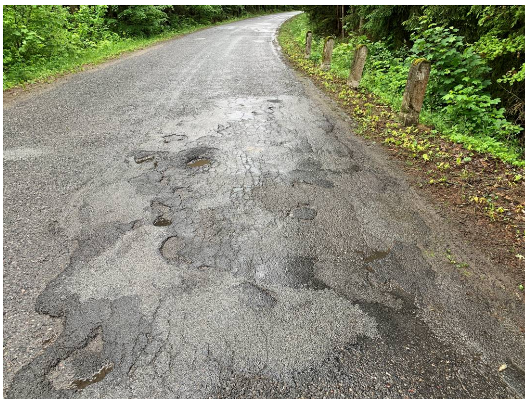
Poruchy Vysprávk, výmoly - Komunikace – od uzlu 2223A061 do uzlu 2241A035 (Podolí I)
