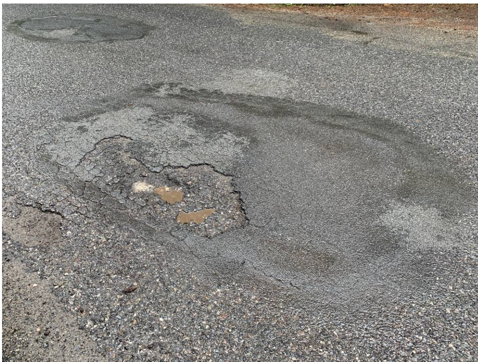
Porucha výtluk - Komunikace – od uzlu 2223A061 do uzlu 2241A035 (Podolí I)
